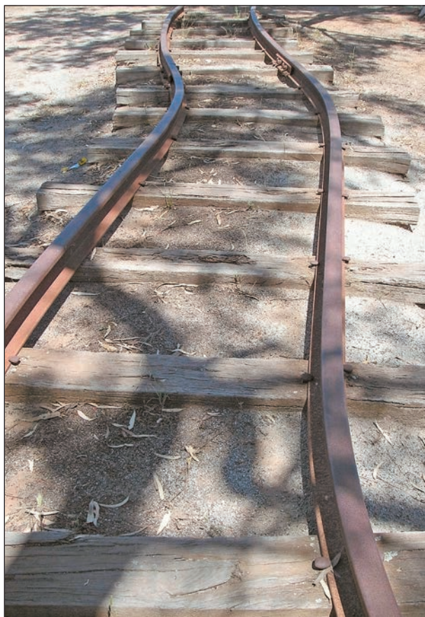
Рис.4. Искривление рельсов железной дороги в Мекеринге.
