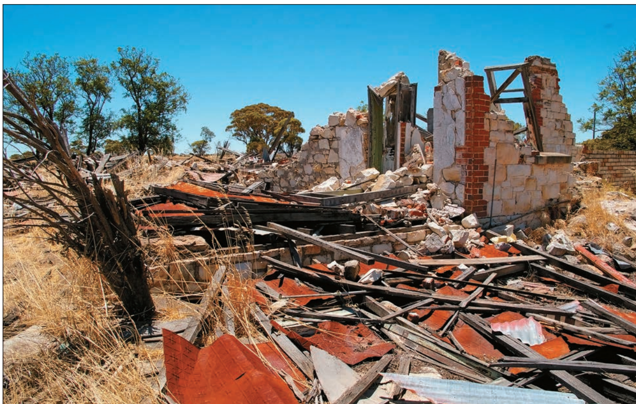
Рис.5. Катастрофическое разрушение жилого дома в Мекеринге.
